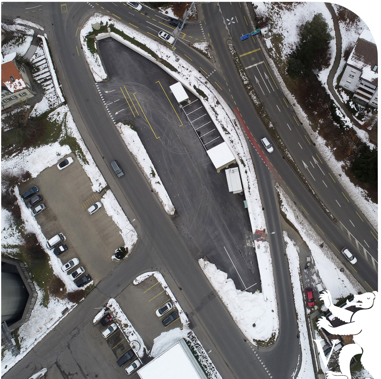
Die provisorische Prüfstelle für Fahrzeugprüfungen des Strassenverkehrsamtes an der Cilanderstrasse in Herisau – Luftaufnahme mit einer Drohne. Foto: Erich Brassel
